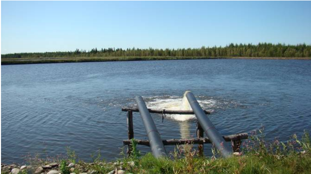
Figure 5. Bassin de récupération (surface)
